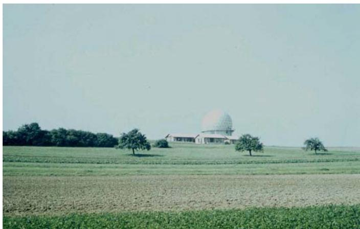
In den Jahren 1959-1965 befand sich auf dem Wangenerberg oberhalb dem Militärflugplatz Dübendorf ein AB-199A Arctic Tower mit dem markanten weithin sichtbaren Fiberglas - Radom. Bis zur Fertigstellung der definitiven Anlage im Hochgebirge war darin die Radaranlage AN/FPS-20A untergebracht.
