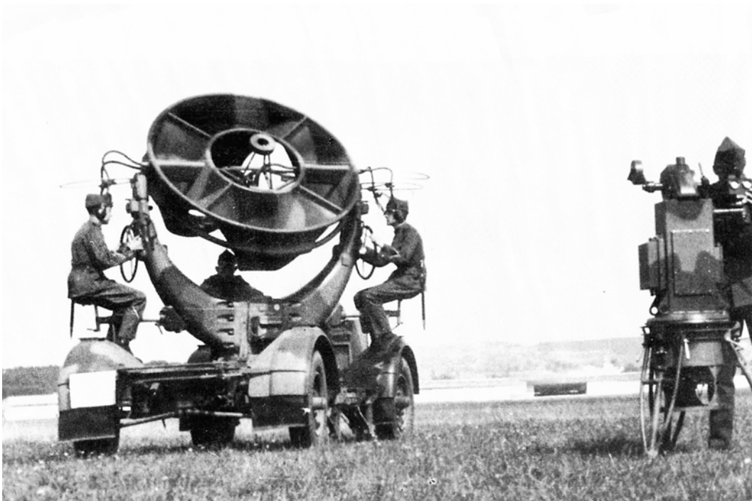
Horchgerät Elaskop mit Richtgerät der Schweizer Fliegerabwehr im Zweiten Weltkrieg
