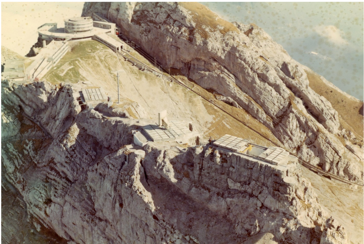
Radaranlage im Bau
