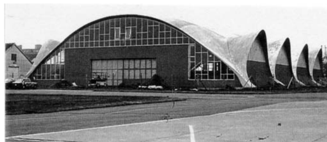
Der Hallenneubau ist fertig
