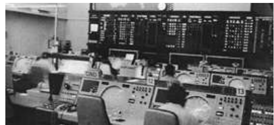
Teilansicht einer Einsatz-Zentrale EZ
