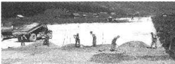
Schaufel und Karrette statt Bagger
