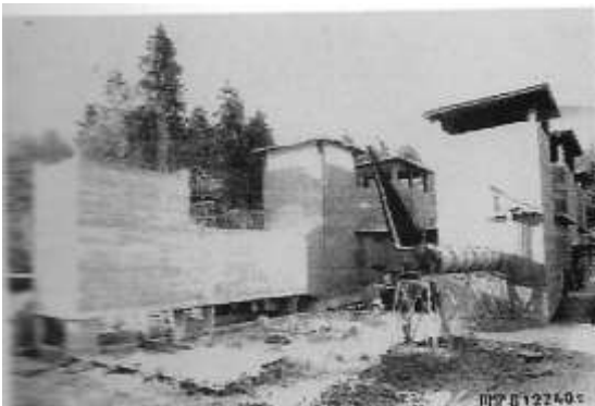
Motorenprüfstand Ennetmoos, einer ist fertig, der andere noch im Bau
