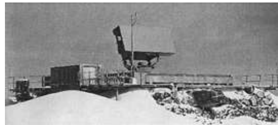
FLORIDA Antenne auf einer Höhenanlage
