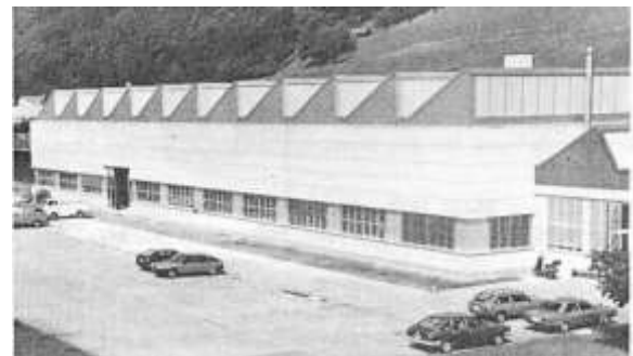
das neue Werkstattgebäude in Buochs für die F/A-18 Triebwerke General Electric F-404
