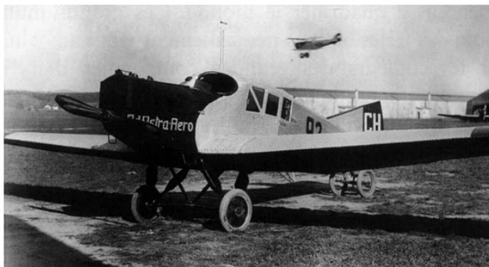
Der Erste Weltkrieg war gerade vorbei, als Hugo Junkers seinem Chefkonstrukteur Otto Reuter (\*1886 †1922) den Auftrag gab, ein Passagierflugzeug zu entwickeln, das vollständig aus Metall hergestellt werden sollte. Es wurden für die Struktur genietete Duralumin-Streben verwendet. Das Flugzeug **Junkers F 13** (interne Werksbezeichnung: J 13) war
