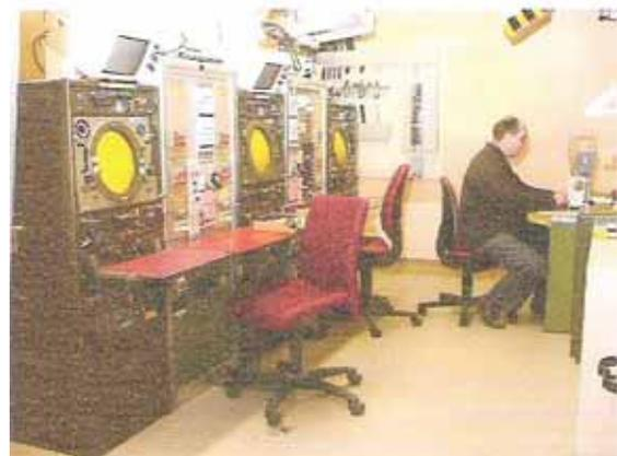
Bedienungspulte für die Quadradar-Anlage. Diese sind abgesetzt von den Antennen, welche auf dem Flugplatz stehen, in der Flugplatzkommandozentrale stationiert.
