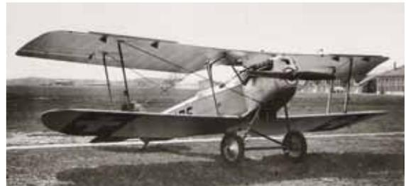
1929: DH-5A. (MVa) K+W, Thun. Stahlrohrumpf. Es wurden 20 Flz mit dem etwas stärkeren Motor LFW III beschafft. Auch wurde dieses Modell von Anfang an mit dem Spaltflügel von Handley Page ausgerüstet.
