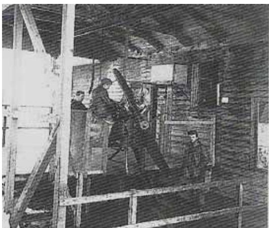
Motorenprüfstand im Gfenn um 1920
