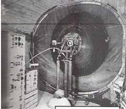
1957: Richtstrahlanlage BBC. Blick von der Kavertenne aus auf die Hinterseite der Parabolantenne.
