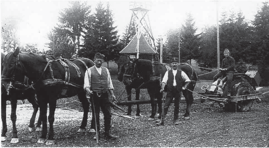
Planierarbeiten / Travaux de terrassement / Lavori del genio civile
