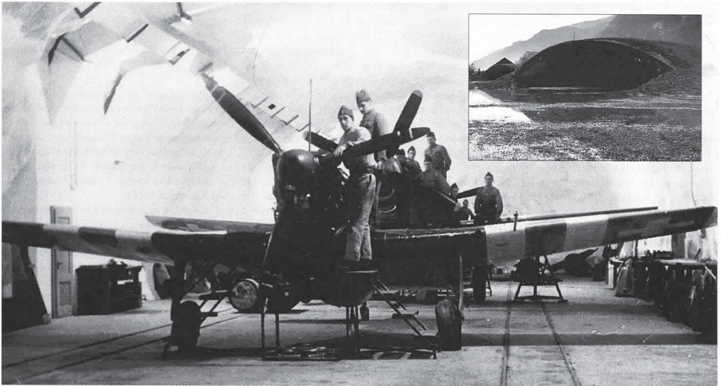
Morane D-3801 in Retablierstollen, Vorläufer der späteren Flugzeugkavernen (kleines Bild: U-43) Morane D-3801 dans une caverne de rétablissement (médaillon: U-43) Morane D-3801 in una galleria di riassetto, successiva denominata caverna (in cornice: U-43)
