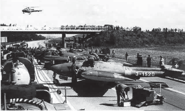
Erste Autobahnlandungen mit Venoms bei Oensingen Premier exercice d'atterrissage sur autoroute près d'Oensingen Primi atterraggi sull'autostrada presso Oensingen
