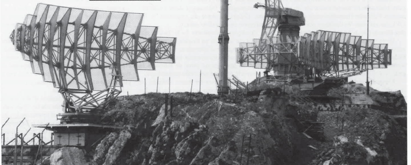
SFR-Höhenanlage der 60er-Jahre / Station d'altitude SFR, années 60 / Impianto d'alta quota SFR
