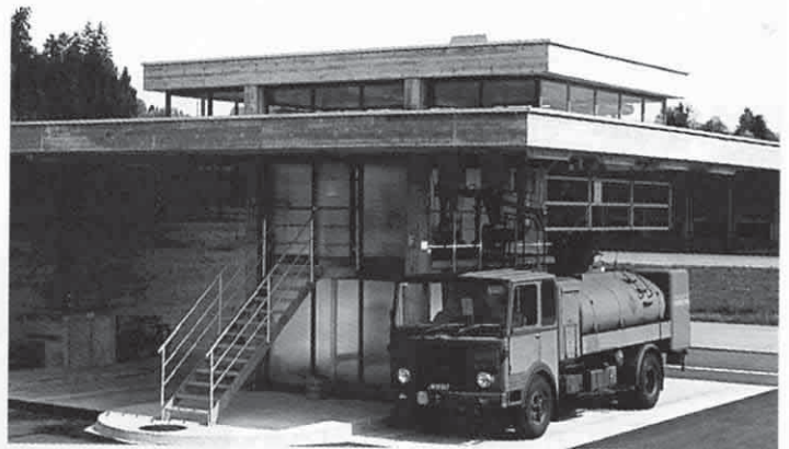
Neue Tankanlage 1983 / Station à kérosène 1983 Nuova stazione di servizio 1983
