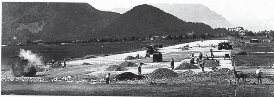
Pistenbau / Construction de la piste / Cantieri per costruzione pista
