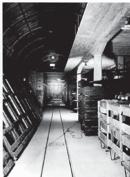
3 ziprese di depositi per materiale sotterranei
