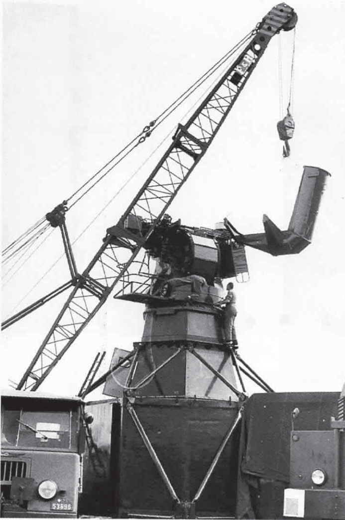
Aufstellen des Radars auf einer Lenkwaffenstellung Assemblage du radar pour engins guidés Bloodhound Assemblaggio del radar per ordigni teleguidati
