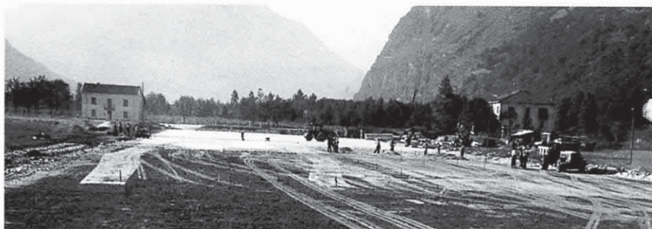
Bau der Piste / Construction de la piste / costruzione della pista
