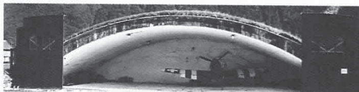
Betonniertes Flugzeugunterstand / Abri avion / rifugio aerei
