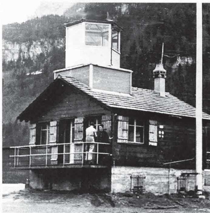
Das alte Funk- gebäude L'ancien bâtiment radio «Torre» radio
